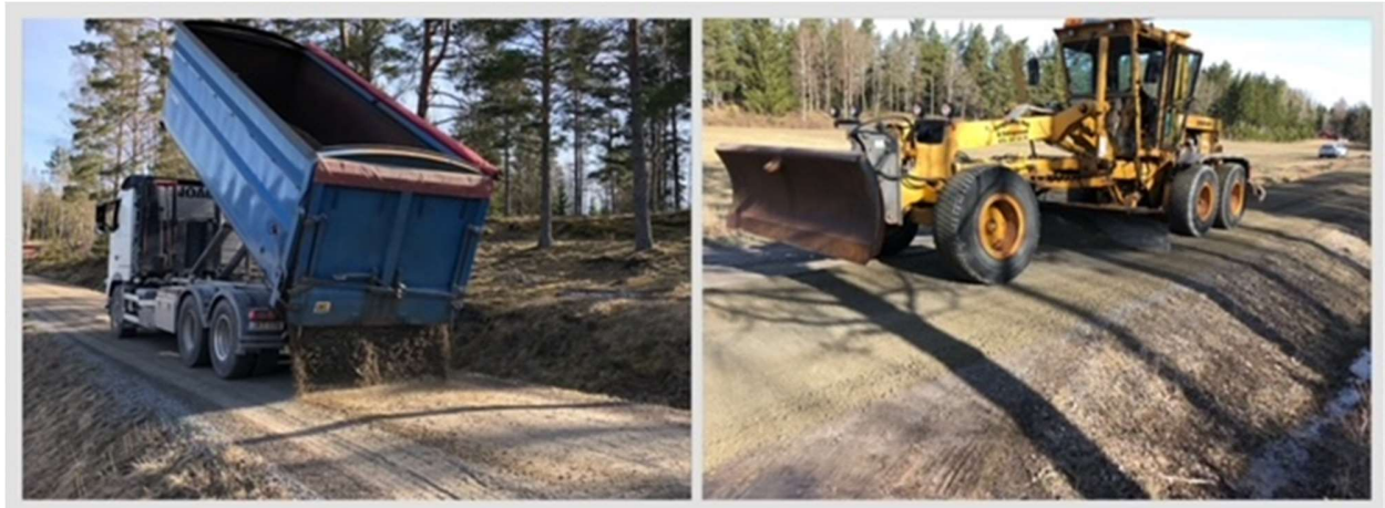
Figur 16 Grusning av teststräcka. Till vänster spridning av grus med tippflak. Till höger hyvling och fördelning av materialet.
