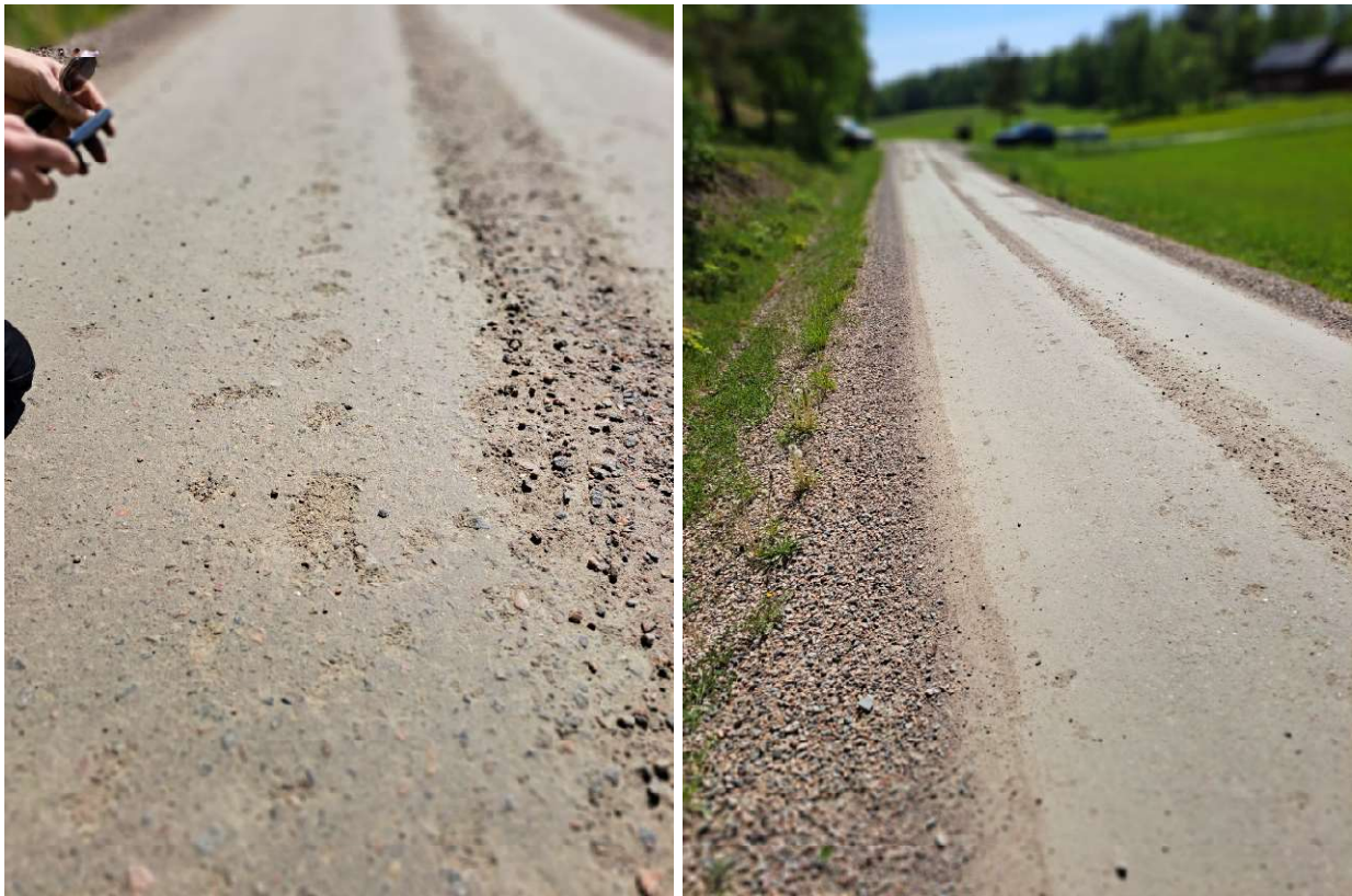
Figur 30. Regelbundna ojämnheter/små skador.
