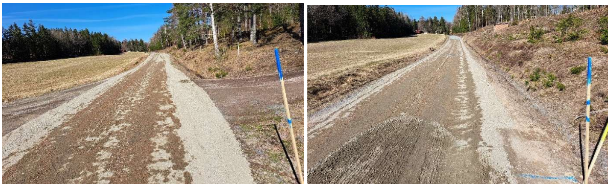
Figur 18. Sträcka 1 (A 0/16) och sträcka 2 (A mitt) efter anläggande av teststräckorna.
