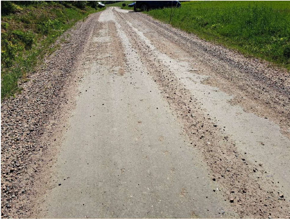
Figur 29. Stäcka 2, material A mitt. Ojämn yta/skada vid övergång från sträcka 1 (mtrl A 0/16).
