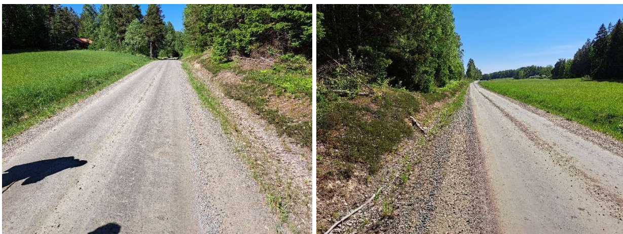
Figur 32. Sträcka 4, material C ovan. Till vänster sedd från söder mot norr. Till höger sedd från norr mot söder.
