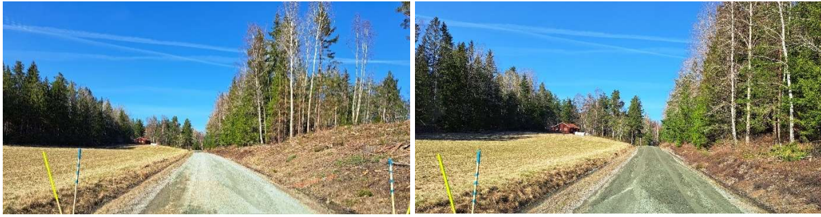
Figur 19 Sträcka 3 (C 0/16) och sträcka 4 (C ovan) efter anläggande av teststräckorna.
